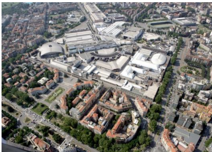
STATO PRE-DEMOLIZIONI E BONIFICHE
